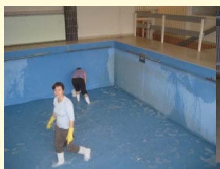
Sanierung Schwimmbad - Grundreinigung und neuer Anstrich
